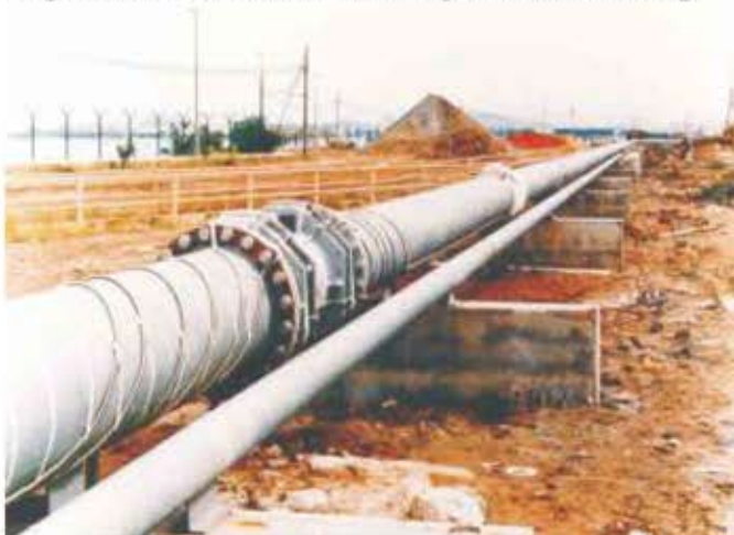
Fig. 5 - Trasee de încălzire electrică pentru conducte lungi
